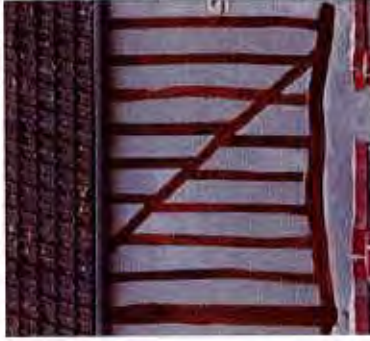
2. Bois - Les structures de pans de bois présentent soit des remplissages de brique enduite ou de torchis, soit, plus fréquemment, des remplissages de brique apparente en appareillage soigné.
