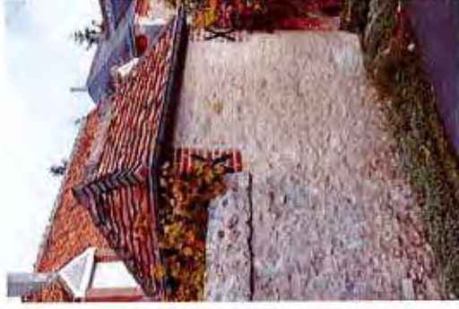
4. Maçonnerie de moellon enduit, et maçonnerie mixte Les maçonneries de moellons enduits « à pierre vue » sont réservées aux constructions modestes et agricoles. L'utilisation de la brique en décor de maçonnerie enduite est très fréquente.
