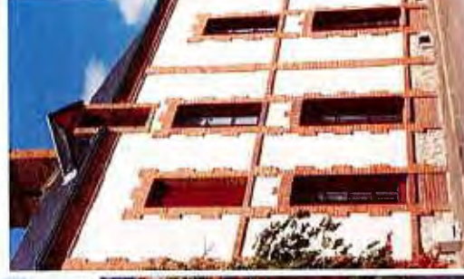
4. Maçonnerie de moellon enduit, et maçonnerie mixte Les maçonneries de moellons enduits « à pierre vue » sont réservées aux constructions modestes et agricoles. L'utilisation de la brique en décor de maçonnerie enduite est très fréquente.
