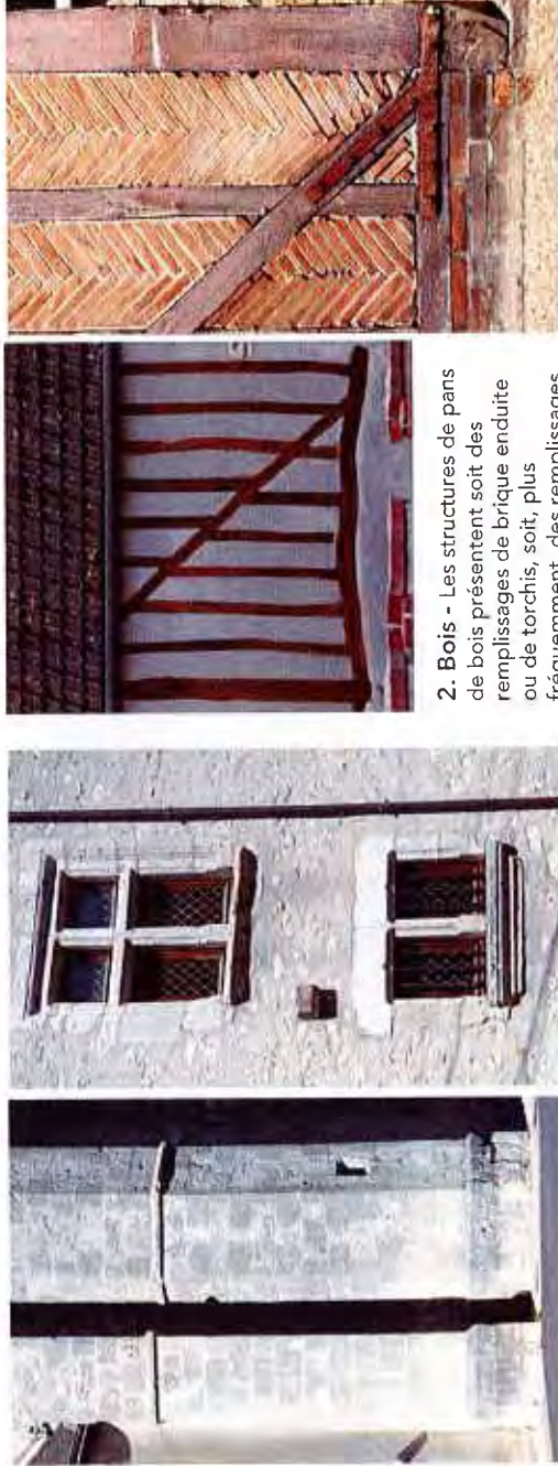
1. Pierre : la pierre de taille est plutôt rare, réservée aux ouvrages (ou parties d'ouvrages) les plus prestigieux et aux cadres de baies, chaînages et corniches.
