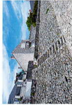
Perré et cale au Vivier (photo Geoscop 2011)
