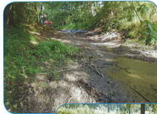
Vue connexion pendant travaux
