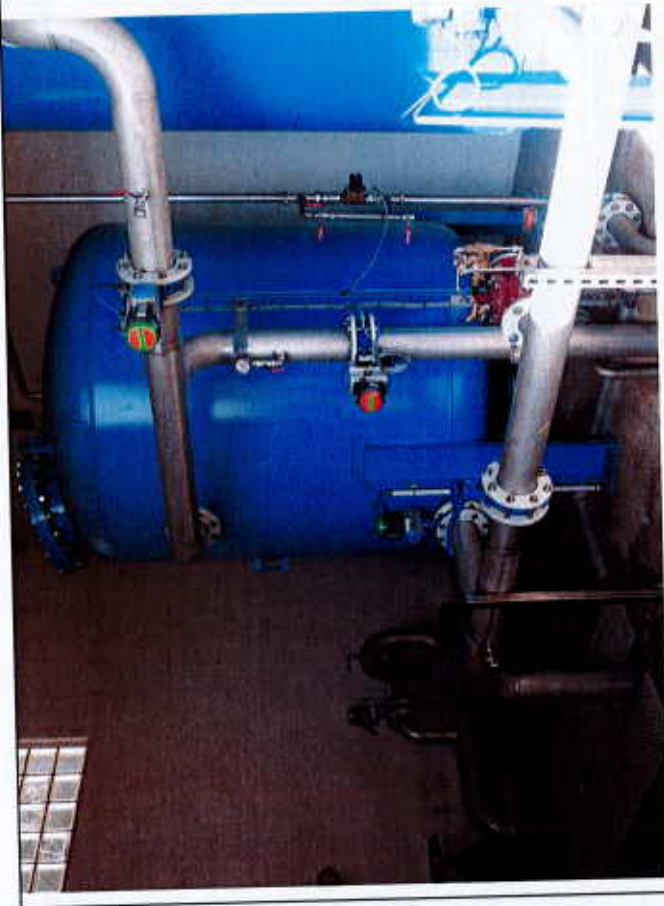
Station de Bauzy rénovée
