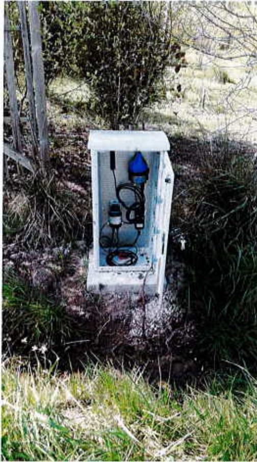
Débitmètre Q5 –Secto 5 – Route de Blois – Lieudit « Le Carroir » Vue du coffret de report d'information + télétransmission
