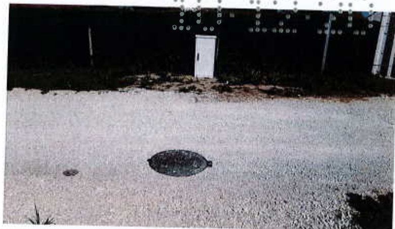
Débitmètre Q4 –Secto 4 – Route de Fleury – Lieudit « Les Varennes » Vue générale
