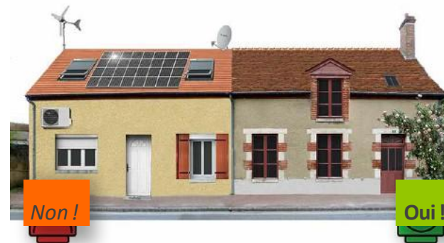
- Installation d'équipements techniques
