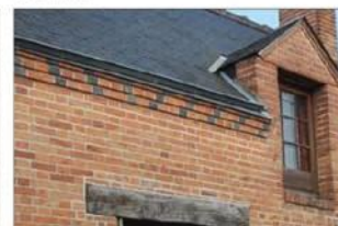
Maçonnerie de brique
