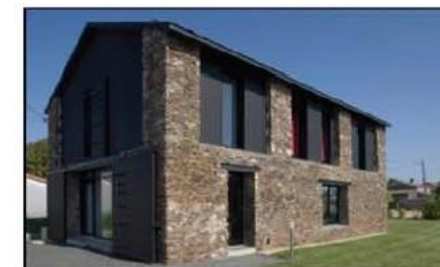
Réemployer les constructions locales (Architectes : NEAU Stéphanie - architecte)
