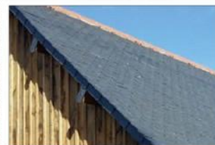
Couverture en ardoise et bardage bois
