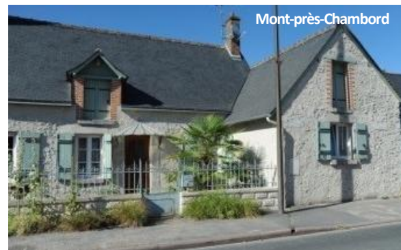
Mont-près-Chambord Alignement de façades principales en léger retrait avec frontages (jardin avant), alignement marqué par des pignons en retour.
