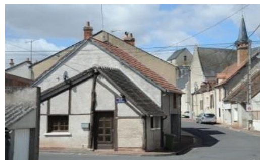
Alignement sur rue suivant la courbe de la route d'Orléans.
