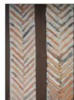
Remplissage en chantignolle disposée en arête de poisson
