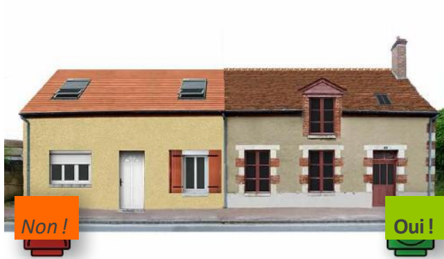
- Réfection des couvertures
