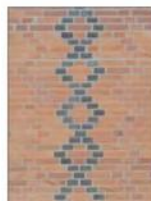
Maçonneries et motifs en briques apparentes : argile de Sologne
