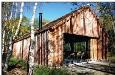
Emprunter les matériaux locaux (Architectes : Laisné et Roussele)
