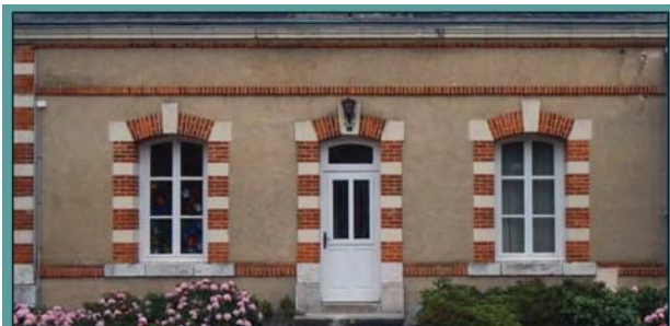
Chainage d'angle, bandeaux, encadrements de baies et corniche - alternance de briques et pierre calcaire
