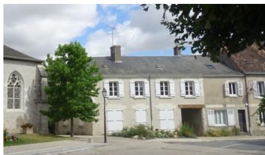
Volumétrie Rdc+1+C, percements réguliers.
