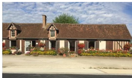
Construction avec pan de bois à remplissage de brique, large trottoir.
