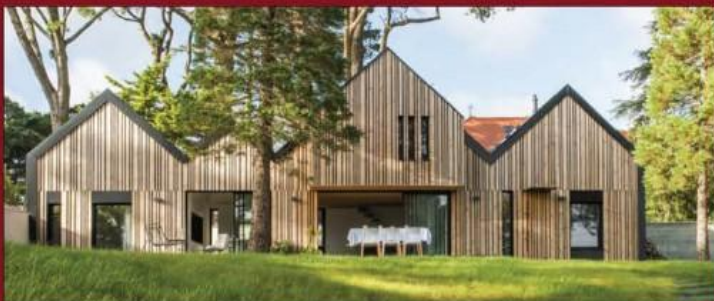
Jouer avec les volumes et les pentes de toiture (Pornic : GREENLEAF LODGE – David Juet)
