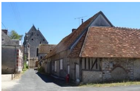
Rue axée sur l'église, bâti en pan de bois et maçonnerie enduite avec décor de briques.
