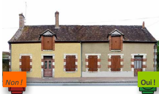
- Réfection des enduits
