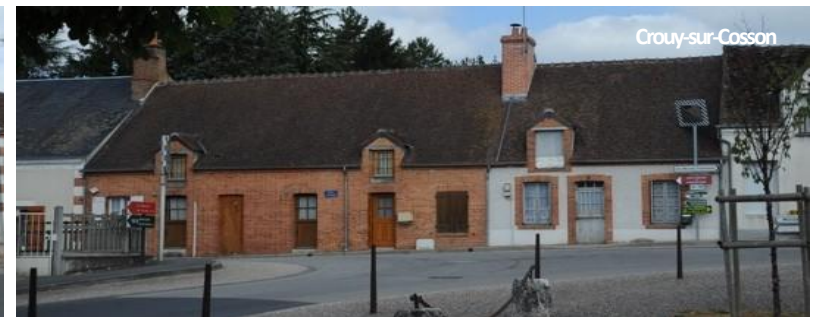
Maçonnerie de briques, ou de pierres enduites avec encadrement de briques.
