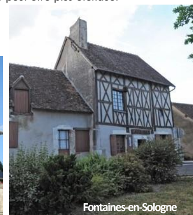
L'ancien Hôtel du Dauphin, pan de bois apparent après suppression de l'enduit (cf carte postale).
