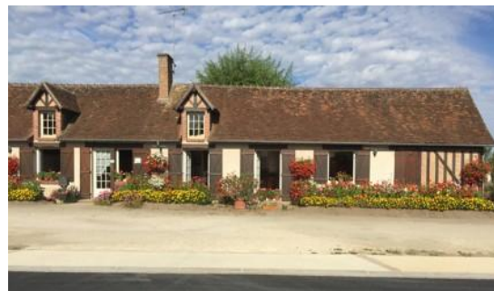
Construction avec pan de bois à remplissage de brique, large trottoir.
