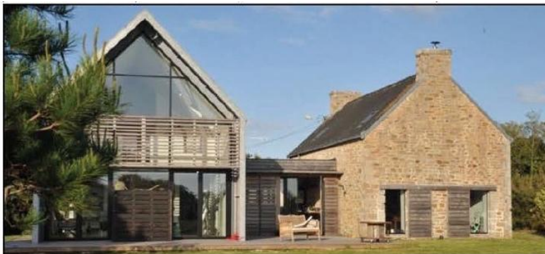
Enchâssement des volumes : dialogue avec l'existant, simulation des volumétries (Architectes : Atelier Arcos Architecture et P. Gautier)
