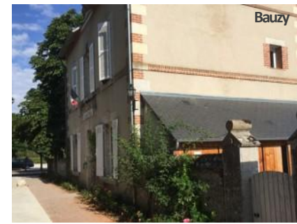
Les aménagements d'espace public récents ont prolongé au sol l'usage de la brique.
