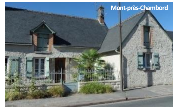
Alignement de façades principales en léger retrait avec frontages (jardin avant), alignement marqué par des pignons en retour.
