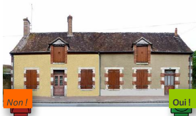
- Réfection des enduits
