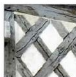
Pan de bois et enduit
