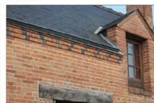
Maçonnerie de brique
