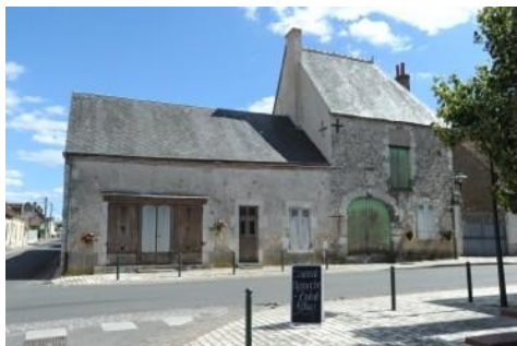
Bâti d'époque médiévale.
