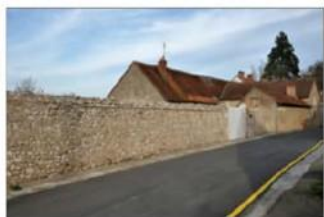
Murs de clôture à l'alignement de la voie formant les cours fermés d'anciens logis (Montlivault)
