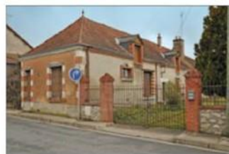
Muret bas surmonté d'une grille ouvragée et piliers en briques - type XX ème (Montlivault)
