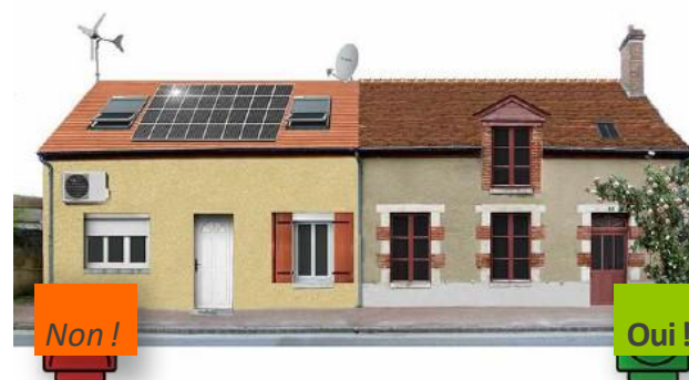
- Installation d'équipements techniques
