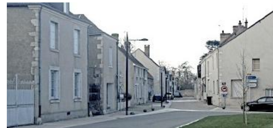
Front bâti continu Rdc+Combles, avec murs gouttereaux sur rue.
