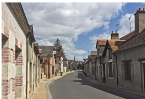
Rue du Faubourg de Guyenne, axe Nord-Sud.
