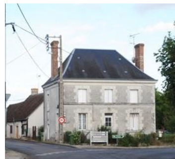
Maison de maître du XIXème s. en maçonnerie de calcaire enduite.
