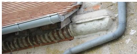
Corniche en brique terminée par une pierre moulurée.
